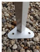
Εικόνα 5: Ποδια με σιδερενια βαση
